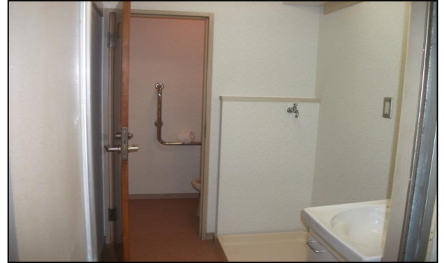
② 洗面所・トイレ方向
