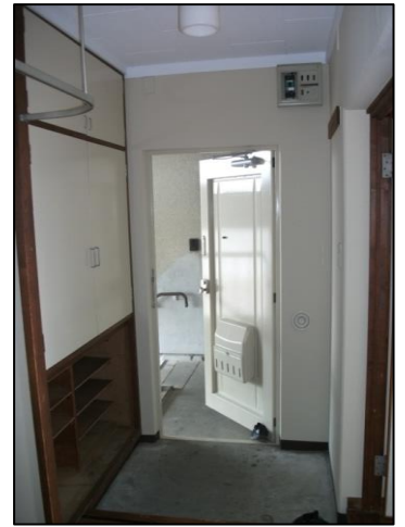
② 廊下奥から玄関
